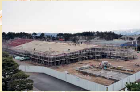
建設工が進む新図書館(12月18日撮影)
