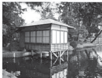
すずみでい「涼亭」
