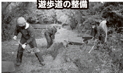
遊歩道の整備
